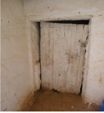
الشكل (4) : صور لأبواب مصنوعة من جذوع النخيل
