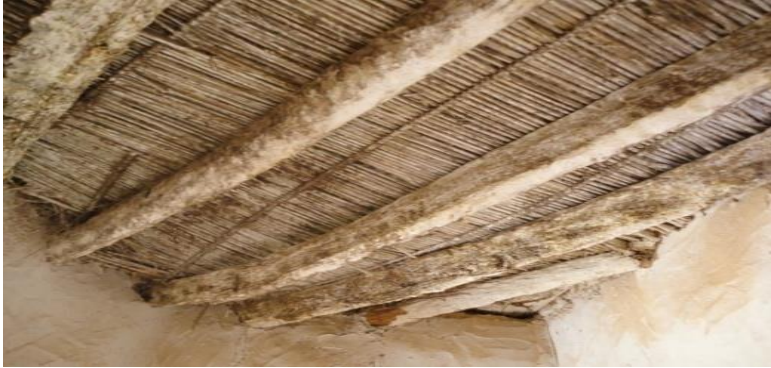
الشكل (5) : نموذج لأسقف من جذوع النخيل
