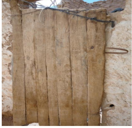
الشكل (4) : صور لأبواب مصنوعة من جذوع النخيل
