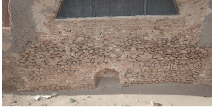
شكل رقم 14 تأثير الأمطار الحمضية في الجهة الشمالية في مبني حمامات الصيد
