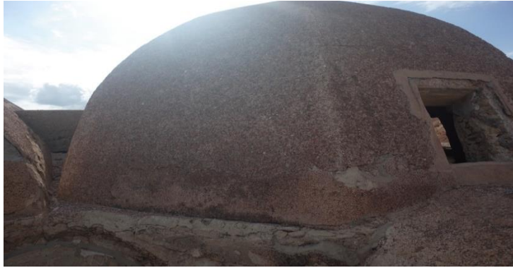
شكل رقم 7 يوضح الطبقة السطحية السوداء علي قبة حمامات الصيد من تصوير
