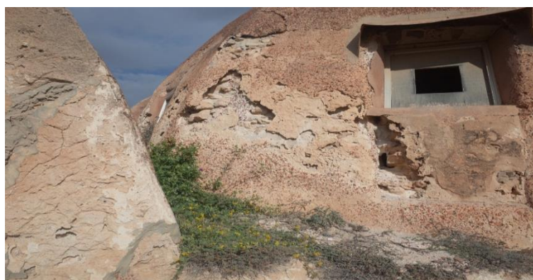
شكل رقم 10 يوضح سقوط طبقة المونة في مبني حمامات الصيد من تصوير
