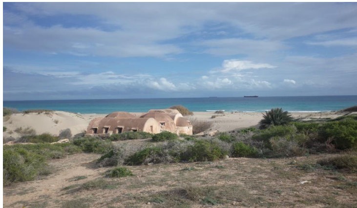
شكل رقم 15 توضح زحف الكثبان الرملية علي مبني حمامات الصيد من تصوير
