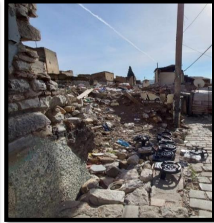
الصورة 14: انهيار الجدران (عن الباحثين)
