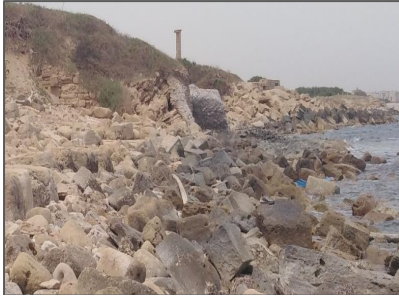
الصورة (17) انجراف أجزاء كبيرة من الميدان القديم بسبب تآكل موضع خط الساحل
